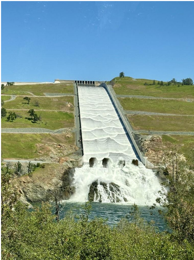
Lake Oroville Spillway
